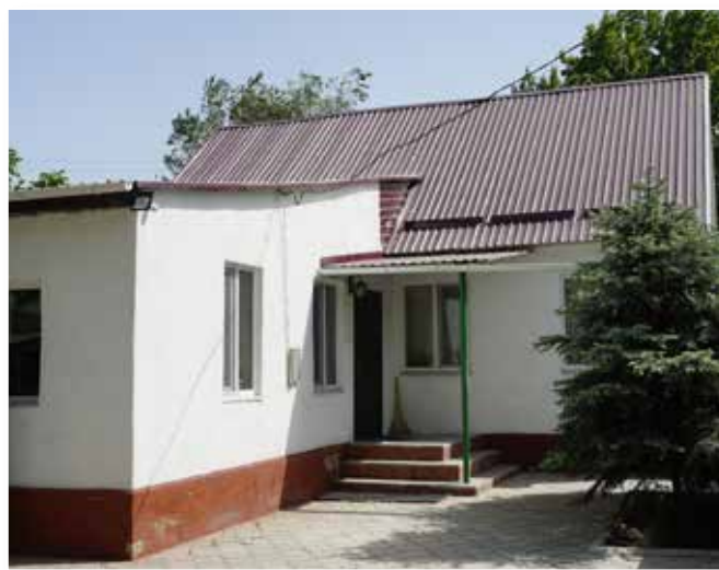
...i po remoncie.
